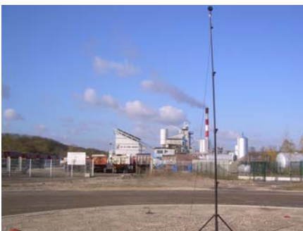
Une mesure de bruit industriel : Val de Seine Enrobés, à Verneuil sur Seine (78)
